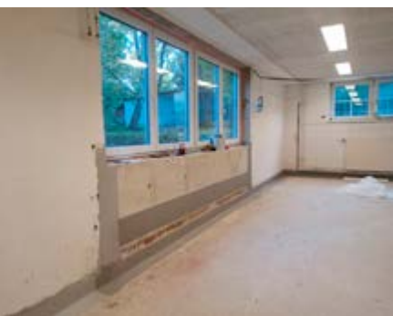
Ein Abdichtungsband wurde rundum eingeklebt
