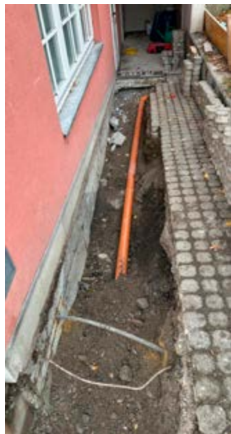
Neue Entwässerung beim Kellereingang
